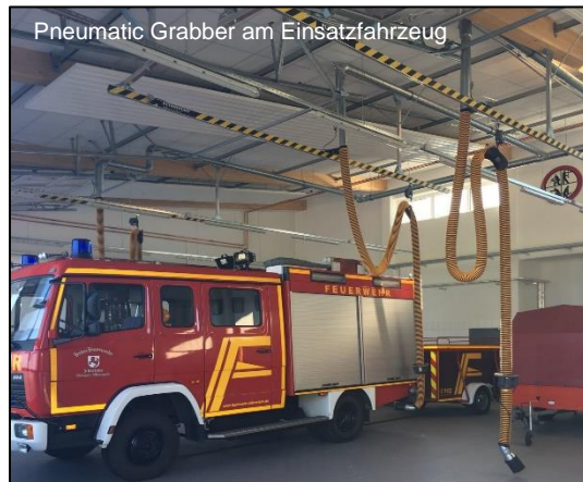
Deckenstrahlplatten in der Fahrzeughalle
