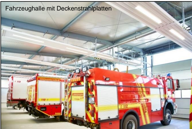
Deckenstrahlplatte und Magnetic Grabber
