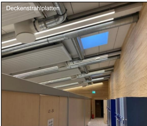
Deckenstrahlplatten und Zuluftauslass
